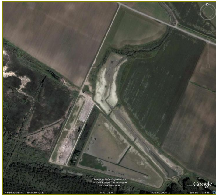
Слика 18 : Локација комплекса РДКО-сателитски снимак
