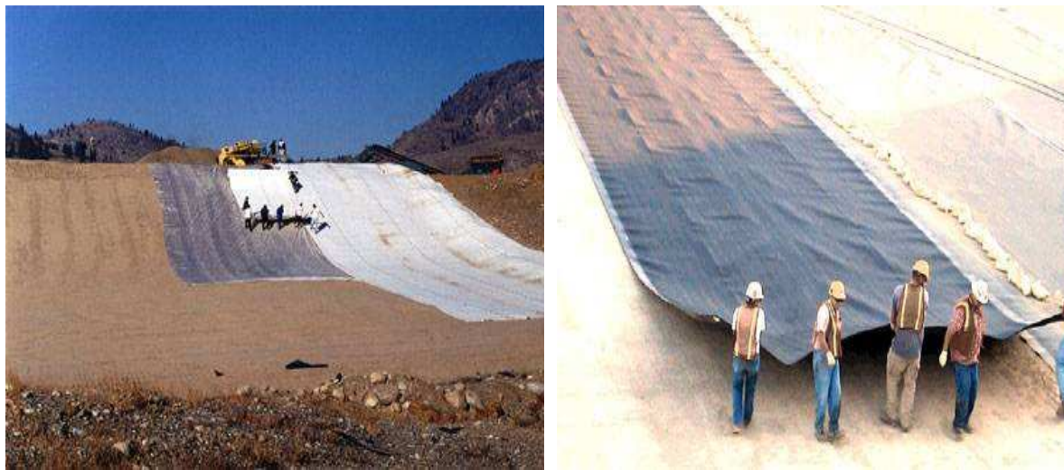
Слика 5.22. Постављања доње непропусне фолије.
