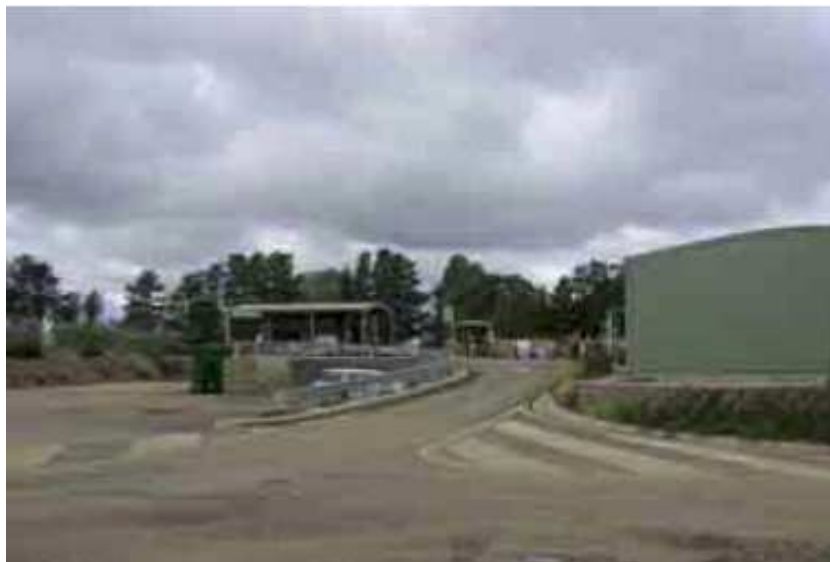
Слика 5.11. Изглед трансфер станице
