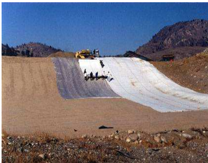
Слика 5.6. Постављање геомембране и геотекстила
