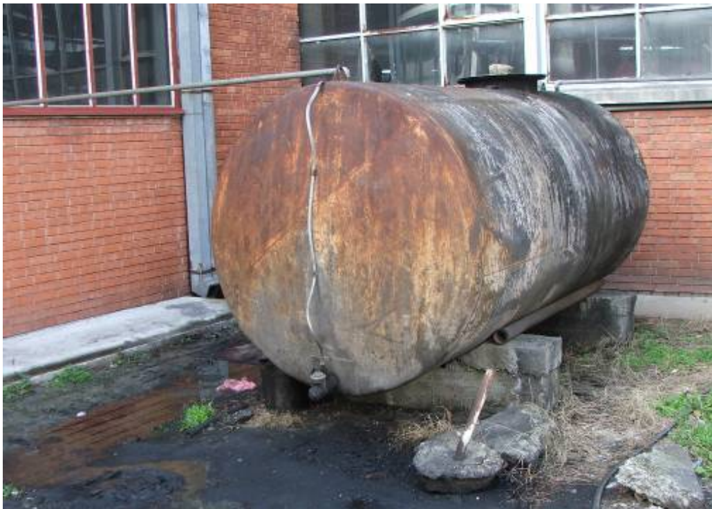
Слика 29. Резервоар запремине 5000 л за прикупљање отпадног уља
