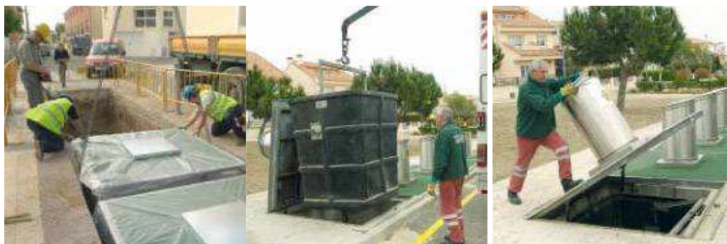
Слика 6.5. Подземни контејнери са пражњењем са дизалицом
