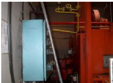
Слика 8. Постројење за сагоревање анатомског и ткивног отпада у ЗЦ Студеница
